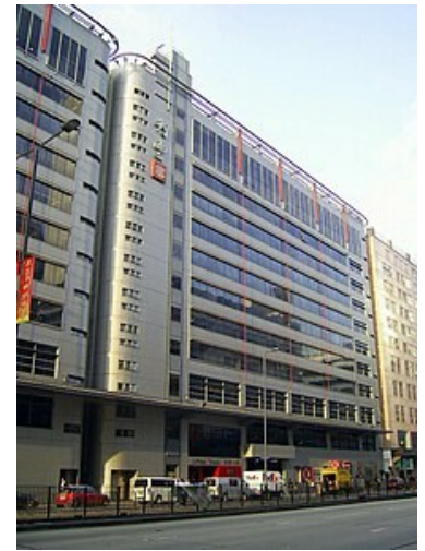
11/2008. Πύργος Lifung των κεντρικών γραφείων στο Cheung Sha Wan
