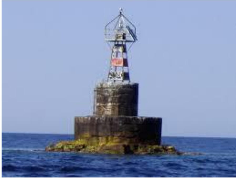
Φωτογραφία 22: Σημερινή κατάσταση στην βραχονησίδα Ζουράφα.
